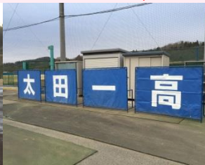
外野フェンス修理
